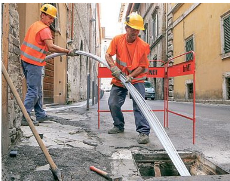
Lavori per la banda larga (Foto archivio)
